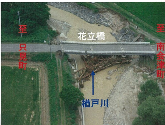
国道289号花立橋
