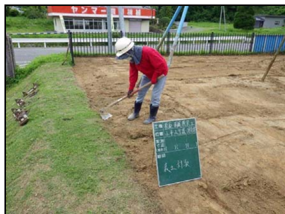
校庭除染工事表土剥取
