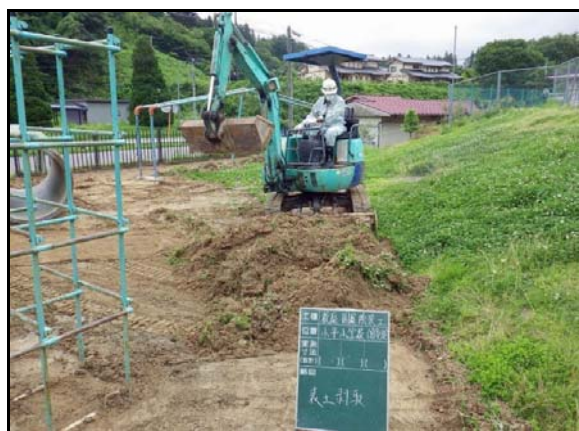
校庭除染工事表土剥取
