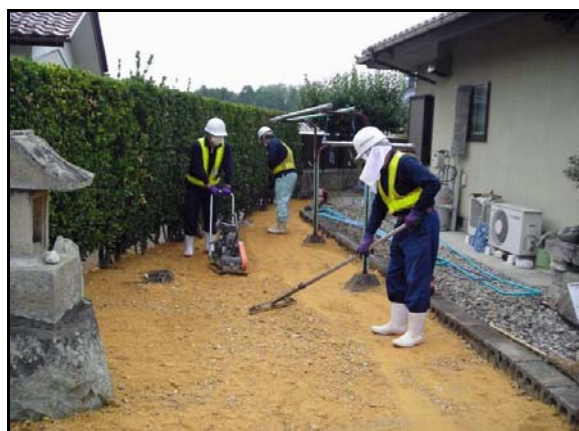
仁井田地区内住宅除染作業
