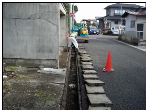
仁井田地区内側溝除染作業
