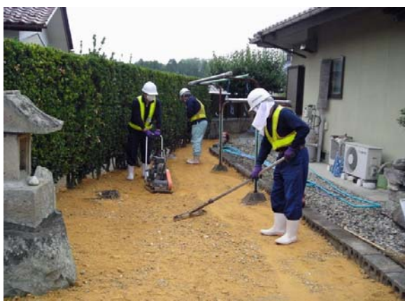
仁井田地区内住宅除染作業
