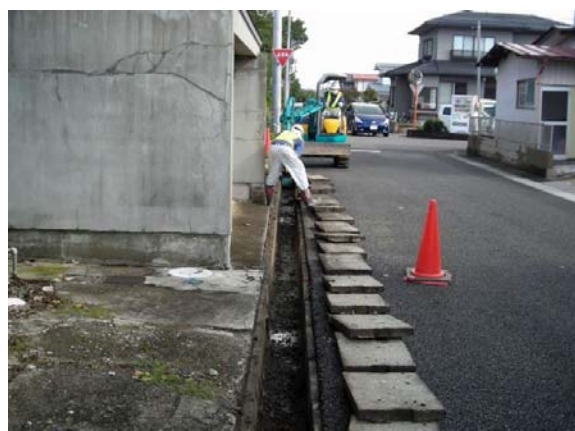
仁井田地区内側溝除染作業
