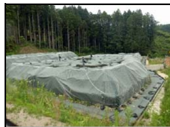
仮置場 搬入済み
