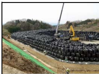
仮置場 搬入中
