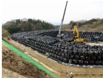
仮置場 搬入中
