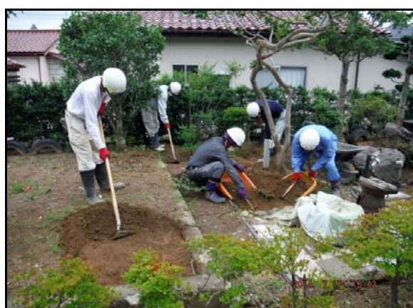
除染作業(表土除去作業)
