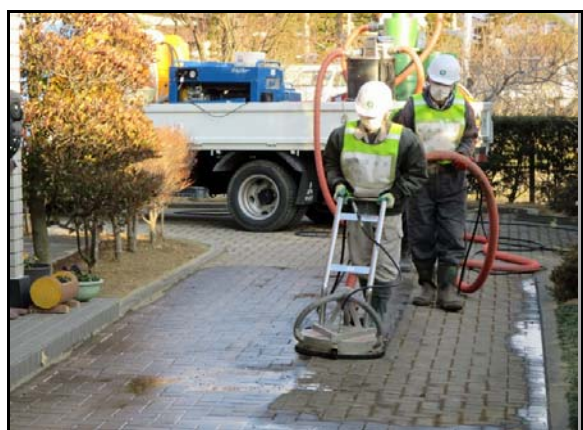
回収型高圧洗浄機による作業
