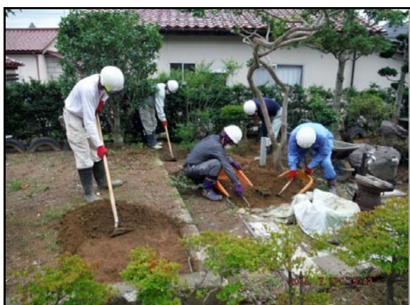
除染作業(表土除去作業)
