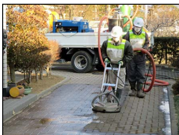
回収型高圧洗浄機による作業
