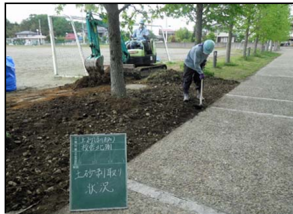
社川小学校除染状況
