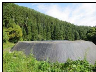
高内仮置場全景
