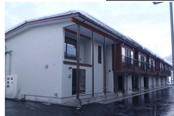
建物外観(南西方向より)
