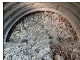
写真1 亀裂の非常に多い安山岩の様子 ※岩塊は小割りしていない
