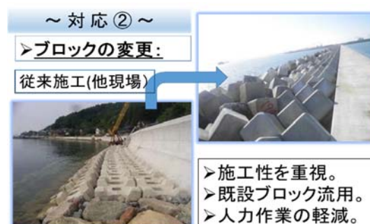
図7 ブロック据付状況
