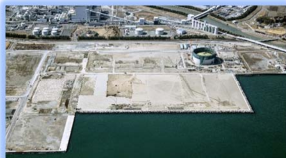
図14 現在の埋立状況
