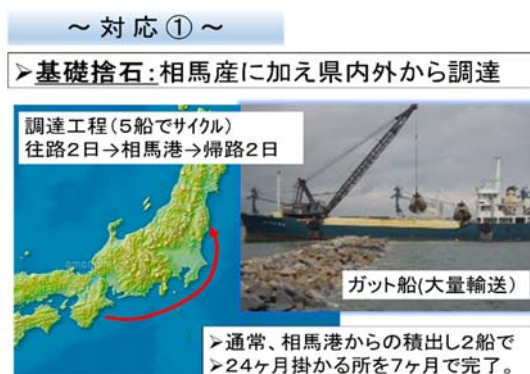
図6 基礎捨石 調達状況
