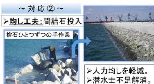
図8 陸側の法面状況
