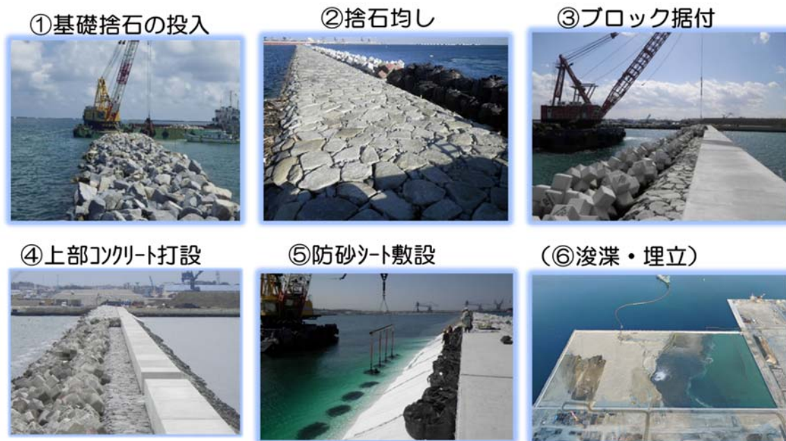
図5 ①～⑤護岸工 施工状況 ⑥埋立工 施工状況
