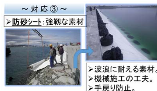
図10 シート敷設状況
