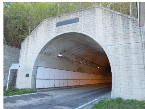
土湯トンネル(猪苗代坑口)
