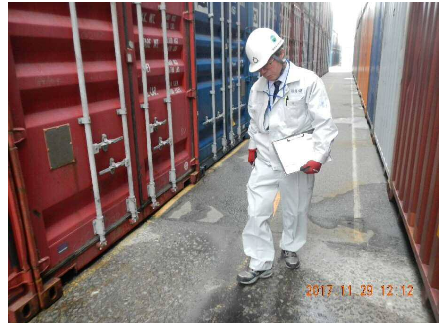
目視点検状況(11月29日撮影)
