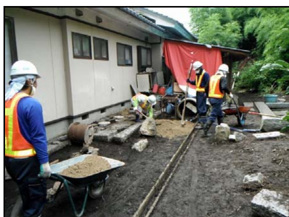
住宅除染実施状況
