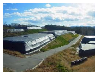
長屋地区仮置場
