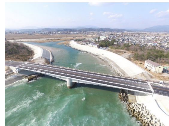
完成した新しい東舞子橋
