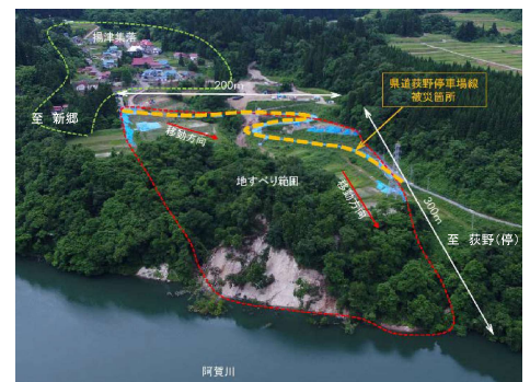
被災箇所写真
