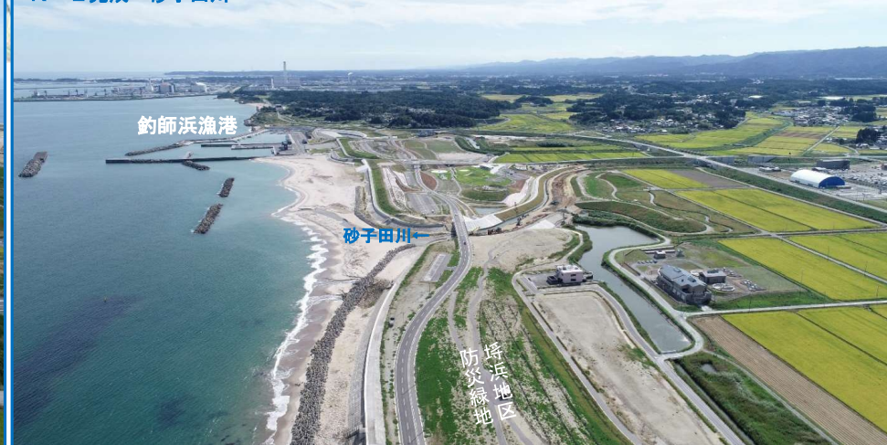
H30完成 埴浜地区防災緑地 R2完成 砂子田川
