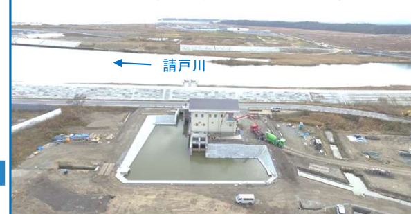
H30完成 請戸中浜地区海岸
