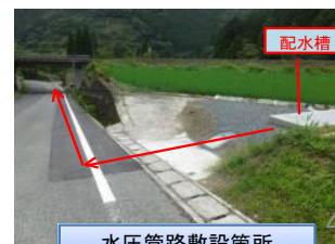
水圧管路敷設箇所
