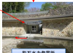
影石水力発電所
