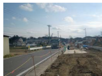
道路改良工事状況
