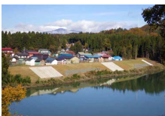
完成した堤防の様子
