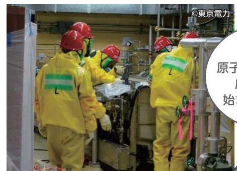
機器の汚染の除去作業（原子炉建屋内）
