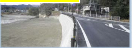
破堤した堤防の復旧完了
