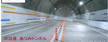
日治道 あつみトンネル
