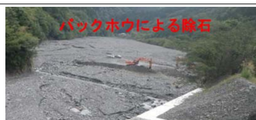
①図4.1 応急対策の除石イメージ(写真は他流域の事例)
