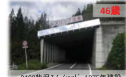
R400牧沢スノーシェッド 1975年建設
