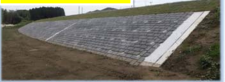
破堤した堤防の復旧完了
