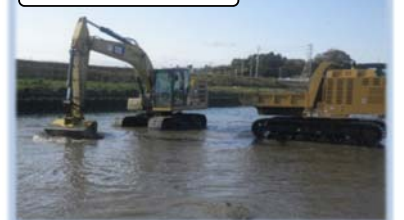
水面下での掘削作業
