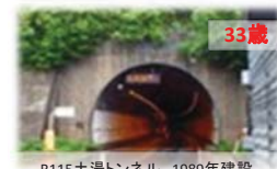
R115土湯トンネル 1989年建設
