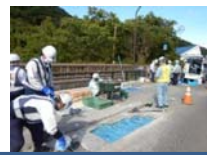
プライマー及び接着剤塗布
