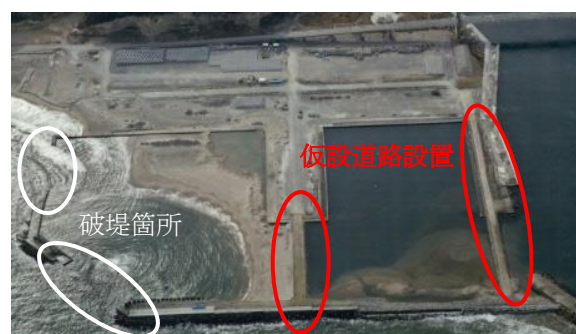
鵜ノ尾岬地区復旧中の状況
