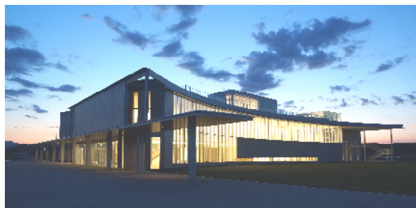
施設全景 南東側より
