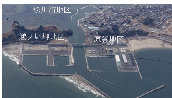
復旧後の松川浦漁港全景
