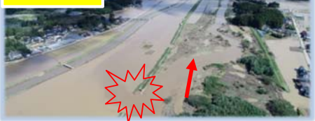
出水時 (堤防破堤)
