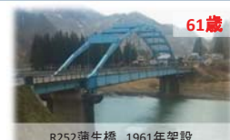
R252蒲生橋 1961年架設
