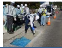
接着剤硬化前に補修材打設が必要
