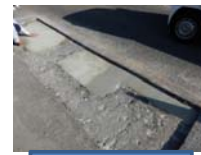
コンクリート打設完了
