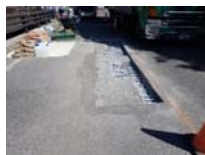
床版取壊し状況
