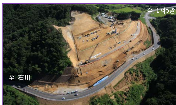
写真-9 第1段階の供用状況（2012年8月）
