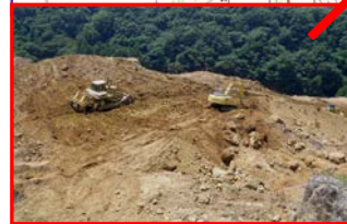
写真-5 頭部排土状況
