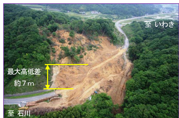
写真-6 準備工（倒木処理）完了状況
