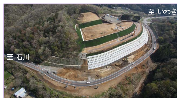
写真-12 第3段階の供用状況（2013年3月）
