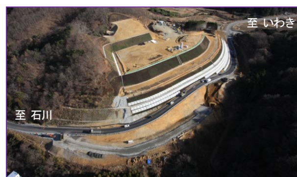
写真-10 第2段階の供用状況（2012年12月）
