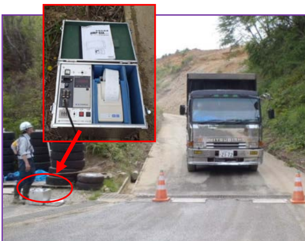
写真-16 トラックスケールの設置
