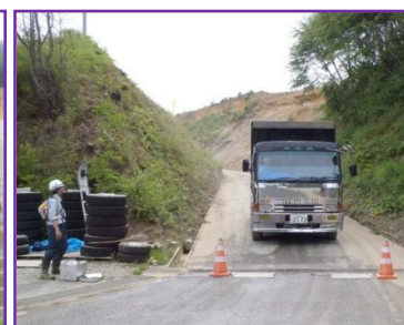
③トラックスケールの設置
