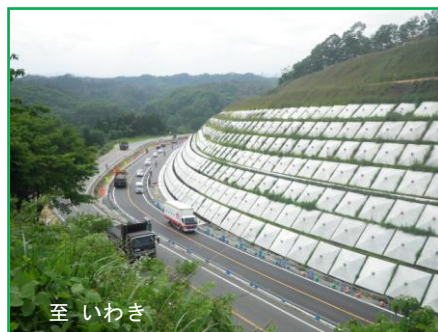
舗装工施工状況（H25年6月中旬時点）
