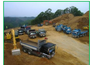
場内ルート見直し前の状況
