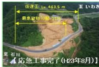
最急縦断勾配11%の仮道工
