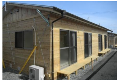
濡れ縁の設置
