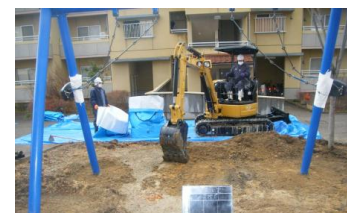
バックホウによる表土除去
