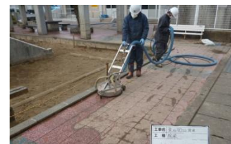
高圧吸引型洗浄機による除染
