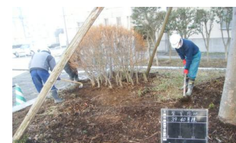
人力による表土除去
