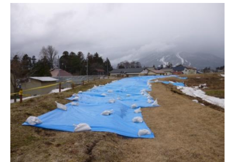
シート張りにより応急復旧
