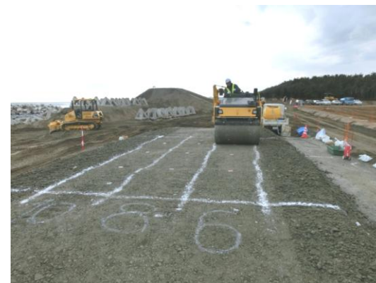
小型振動ローラ(4t)による締固め状況 (試験施工 1/21～1/26)
