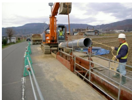
塩化ビニール管布設状況
