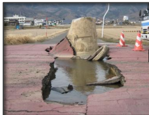
被災状況(H23.3)
