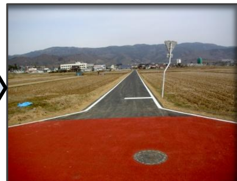
工事完了(H24.3)
