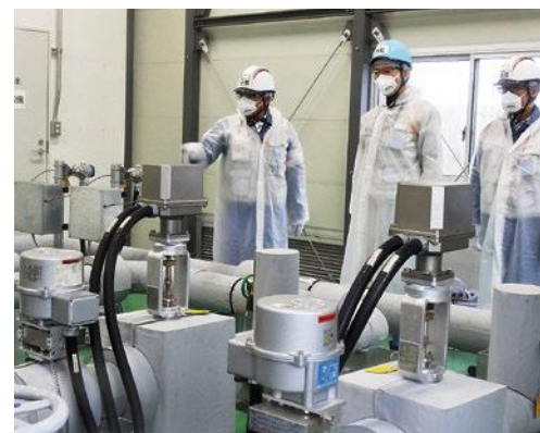
緊急遮断弁を確認する様子
