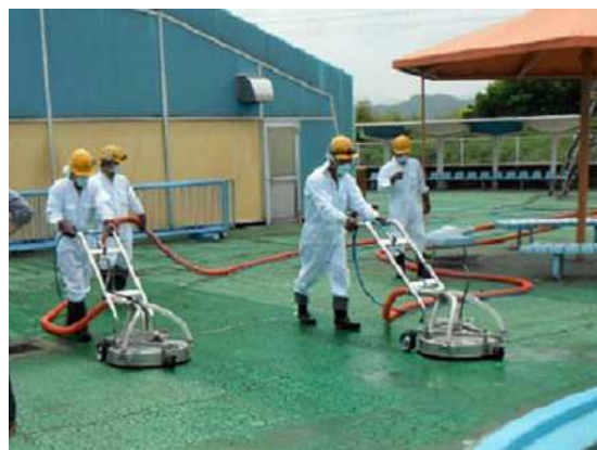
同時吸引型高圧洗浄実施
