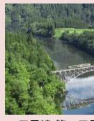
只見線 第一只見川橋梁
